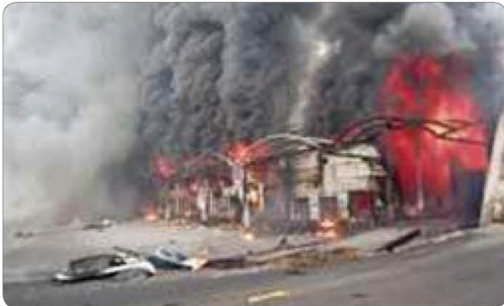
이천 물류 냉동창고 신축공사 화재('08.1.7 사망 40, 부상 10)
