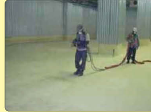
냉동창고 벽면·바닥 스프레이 시공
