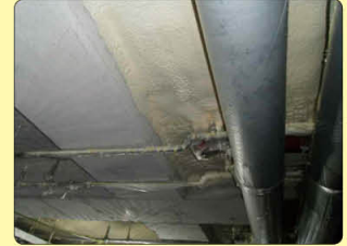
일반 건축물 천정부 스프레이 시공
